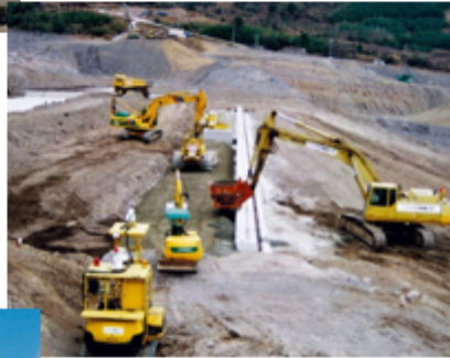
コンクリート打設
