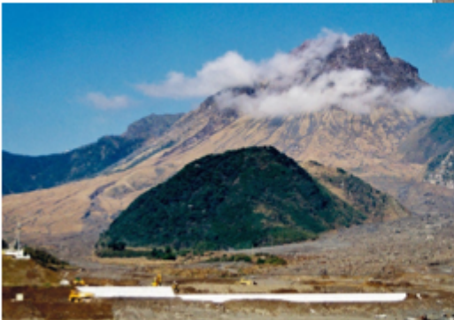
ブロック完了全景
