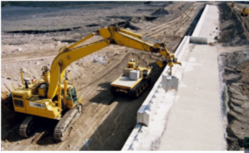
ブロック設置
