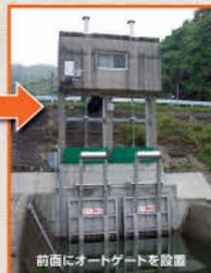
オートゲートは通常時「開」状態ですが、津波やゲリラ豪雨などによる突発的な水位上昇に対しては操作人の操作なしに「バランスウエイト」の作用により無動力で自動閉扉します。また外水位が低下すると、自動開閉して内水排除を行うので操作人の危険作業を回避できます。
