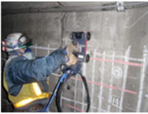
①鉄筋探査
