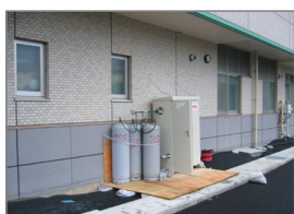
新潟中越沖地震 老人福祉施設
