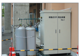
新潟中越沖地震 老人福祉施設
